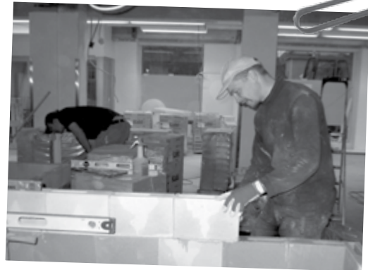
”Pienet rakentajat me, tiilen tiileen liitämme...” Rainer (vas.) ja Markku keittiön ja vessan seiniä muuraamassa.
